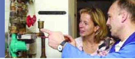
Ältere Heizungsanlagen sind durch die größeren Rohrdurchmesser häufig strömungsgünstiger gestaltet. Bei überdimensionierten Rohrleitungen mit sehr geringen Druckverlusten bewirkt jedoch die Überlagerung durch den Schwerkrafteinfluss eine Reduzierung des Gesamtdruckverlustes in Höhe von 10 - 15 %.
